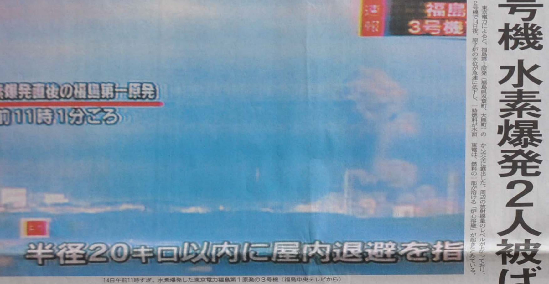
14日午前11時すぎ、水素爆発した東京電力福島第1原発の3号機(福島中央テレビから)
